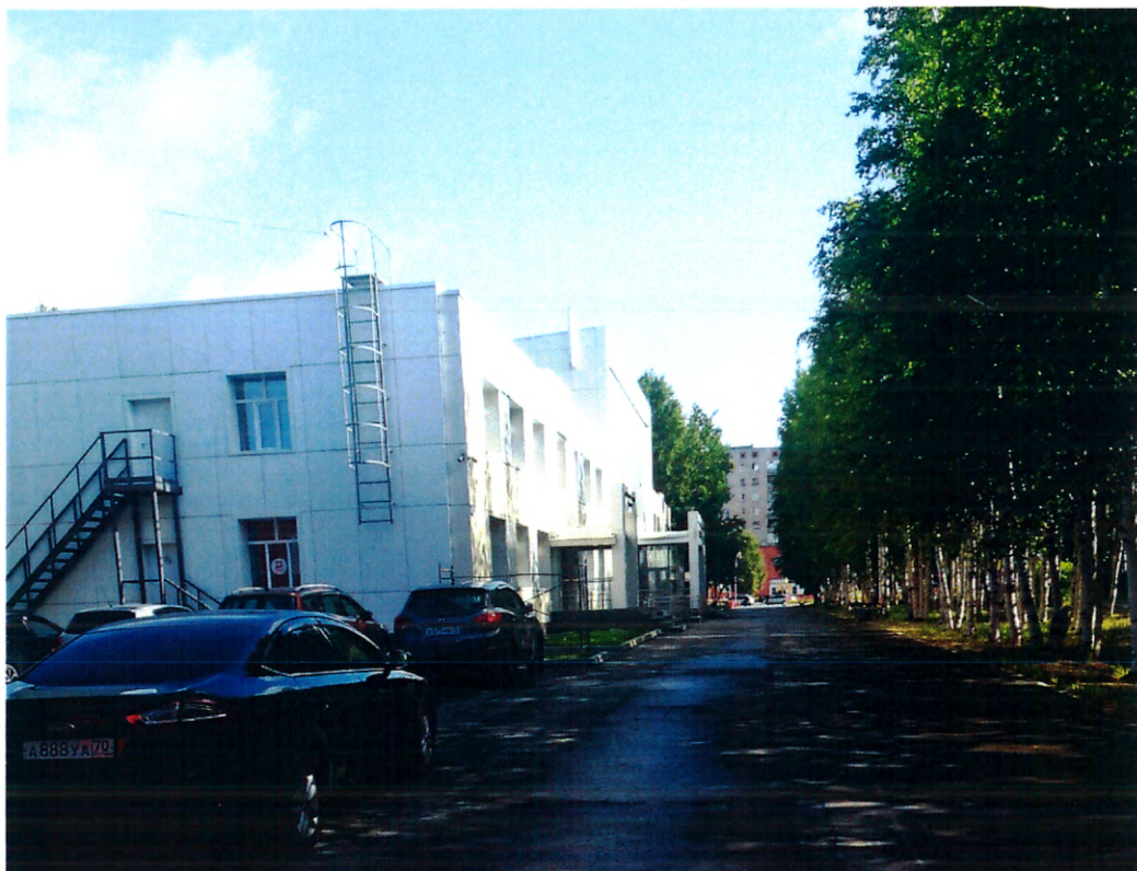
Фото №7-Въезд на территорию МБУДО «ДШИ»
