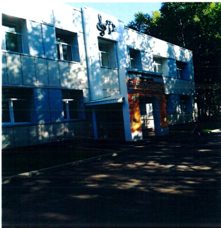
Фото № 9 – Входная дверь №1. Боковые края ступеней не примыкают к стенам и должны иметь бортики.
