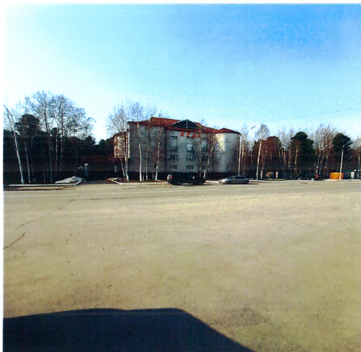
Фото №9 – Автостоянка. Отсутствует знак (автостоянка), также отсутствуют парковочные места для инвалидов.
