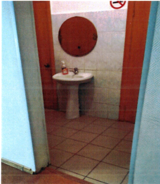
Фото №13 Туалетная комната
